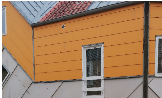
Intakte facadeplader.
