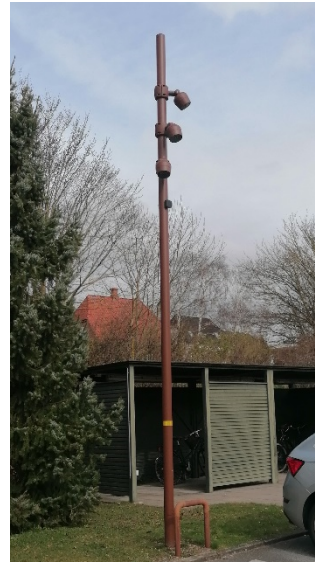
Mast ved parkering,
