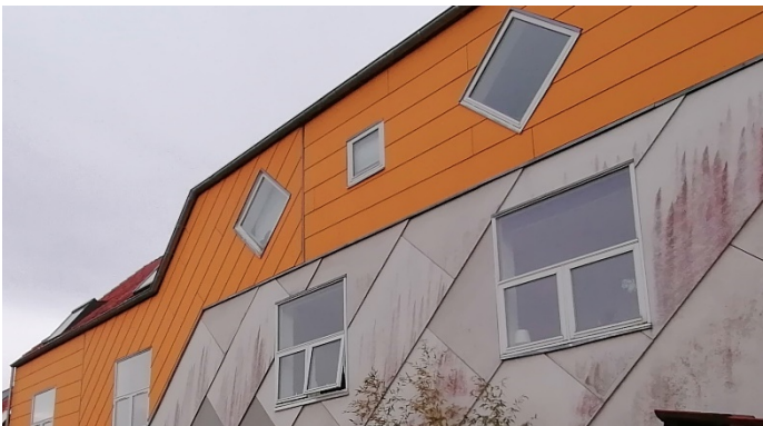
Zinksålbænk ved vinduer i facade med fibercementplader
